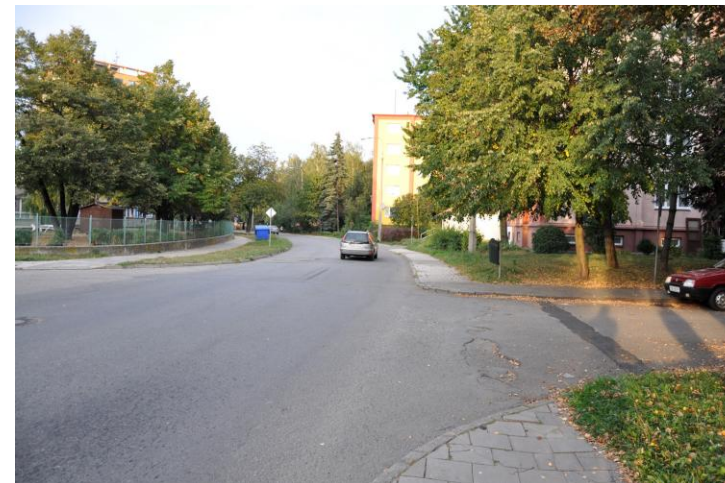
Absence přechodů pro chodce, oprava povrchu komunikace, umístění zvýšeného chodníkového přejezdu
