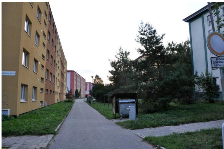
Špatný technický stav přístřešků pro popelnice
