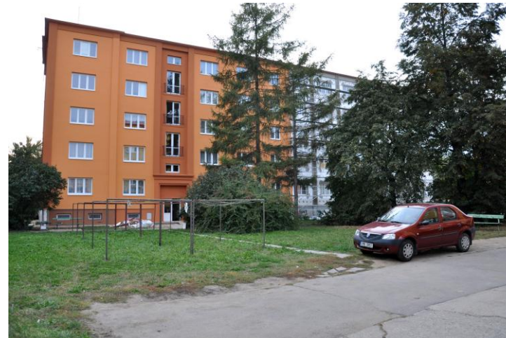
Nevyhovující sušáky na prádlo, odstranění přebytečných prvků
