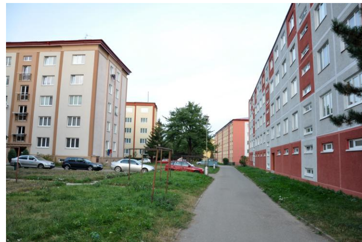
Nevyhovující sušáky na prádlo, výměna venkovního osvětlení, odstranění přebytečných prvků
