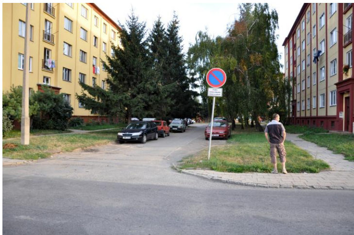
Parkování bez organizace: absence zálivů a materiálového a barevného odlišení parkovacích stání, zúžení průjezdného profilu
