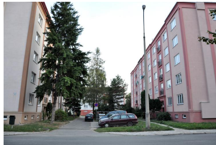
Absence přechodů pro chodce, špatný technický stav chodníků, zúžený průjezdný profil z důvodu neorganizovaného parkování, umístění zvýšeného chodníkového přejezdu
