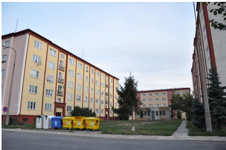
Popelnice a tříděný odpad nejsou kryté a nejsou odděleny od chodníku, doplnění laviček, odpadkových košů
