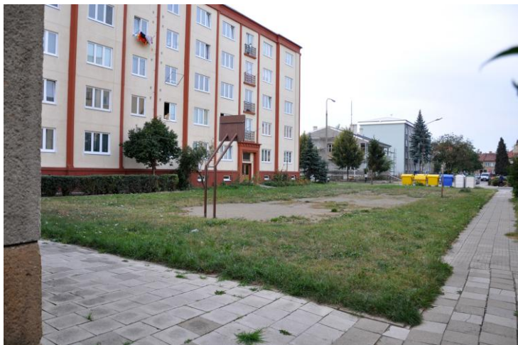
Špatný technický stav hřiště, navržena rekonstrukce
