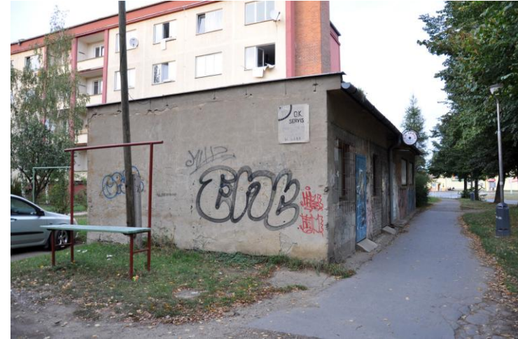
Demolice nevyužitých, chátrajících objektů (v případě využití provést opravy a rekonstrukce)
