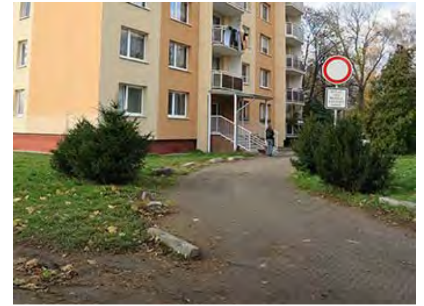
Provizorní průjezd kolem bytového domu č. 9. Zcela nevhodné řešení.
