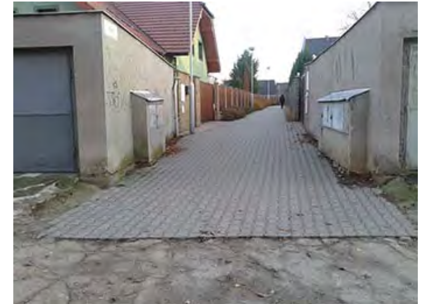
Chodník propojující sídliště se zastávkou MHD na ul. Drozdovice
