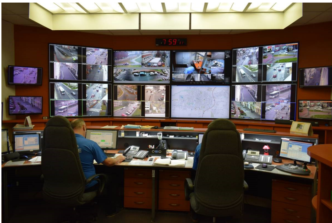
Obr. 5 Operační středisko – stav 2019
