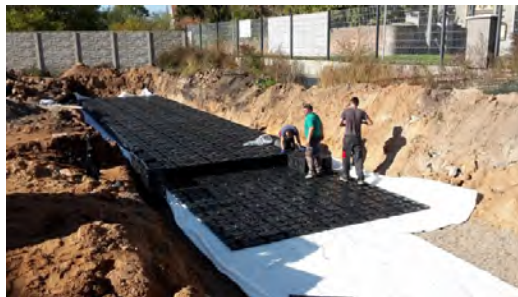
Instalace zasakovacích boxů v Rosicích
