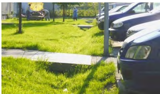
Zasakovací průleh u parkoviště (zdroj: www.tzb-info.cz)
