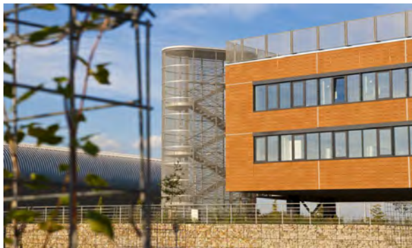
Inteligentní budova univerzitního kampusu Masarykovy univerzity v Brně využívající BMS (zdroj: www.dotknisevedy.cz )
