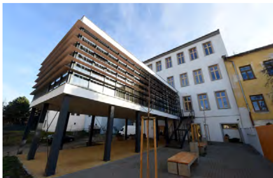
Slunolam na budově knihovny v Bílovci (zdroj: www.patriotmagazin.cz )
