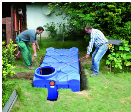
Instalace podzemního zásobníku k jímání dešťové vody
