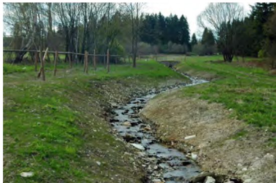
Revitalizace Krkavčího potoka v Rýmařově (zdroj: www.strukturalni-fondy.cz ).
