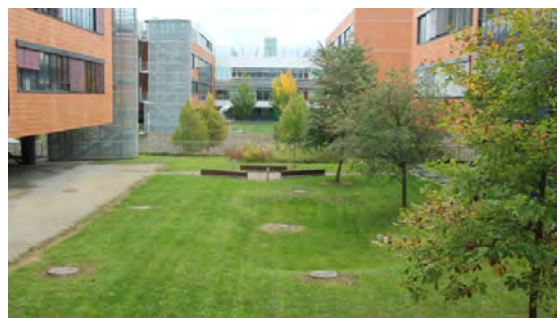
Povrchové vsakování dešťové vody pomocí zasakovacích průlehů a rýh mezi pavilony kampusu Masarykovy univerzity v Brně-Bohunicích. (zdroj: www.tzb-info.cz)
