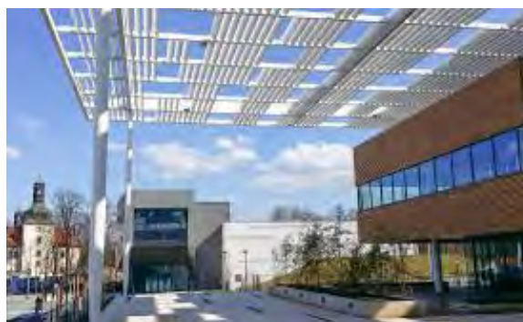
Mobilní stínící systém v mezinárodním výzkumném laserovém centru ELI Beamlines v Břežanech u Prahy (zdroj: www.abadia.cz )
