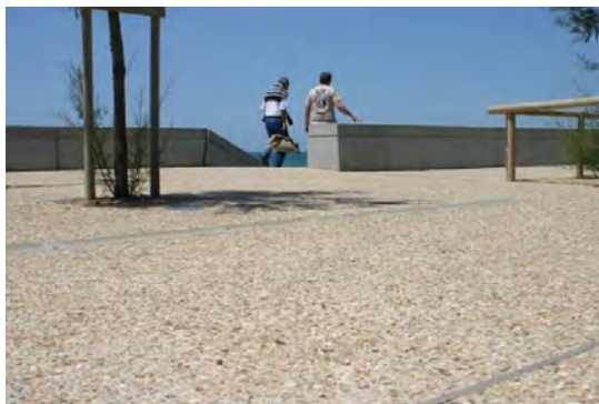
Kombinace světlé barvy a povrchu z porézního betonu (zdroj: www.stavbaroku.cz ).
