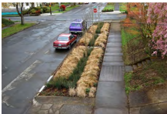
Bioswale mezi silnicí a chodníkem (zdroj: survivalfarm.wordpress.com)
