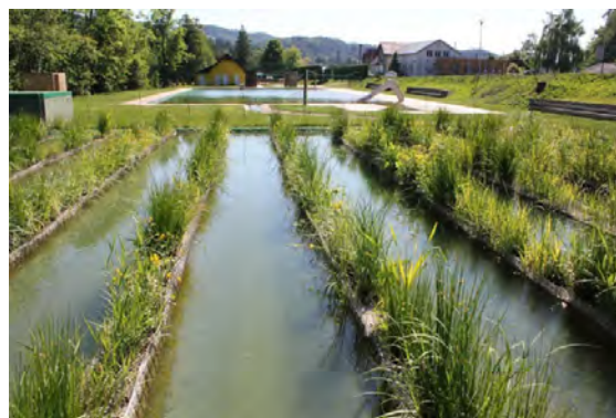
Biotop Bečva v Prostřední Bečvě, v popředí nádrž na čištění vody osázená vegetací (zdroj: www.biotopbecva.cz )
