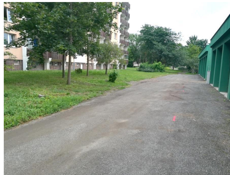
Nezpevněná komunikace kolem garáží za BD č.p. 3764 – 3767.
